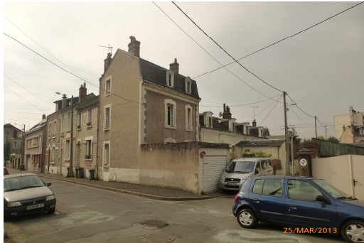
EXISTANT FACADE SUR RUE
