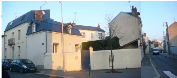
EXISTANT FACADE SUR RUE
